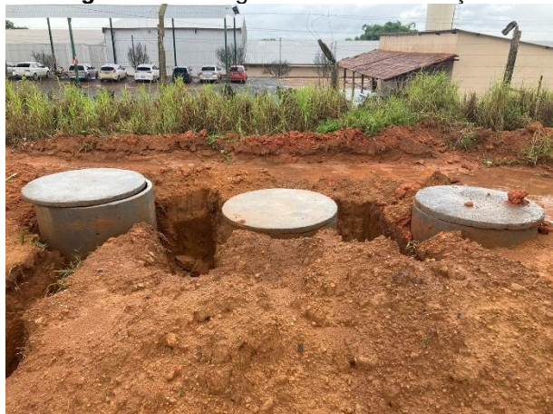
Figura 14: Biodigestores em construção.
