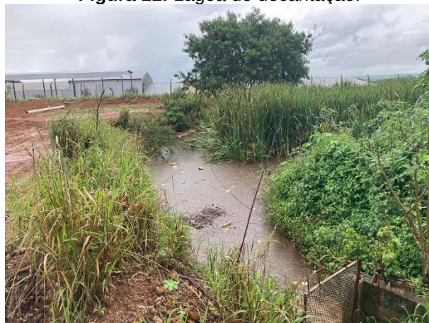
Figura 11: Lagoa de decantação.
