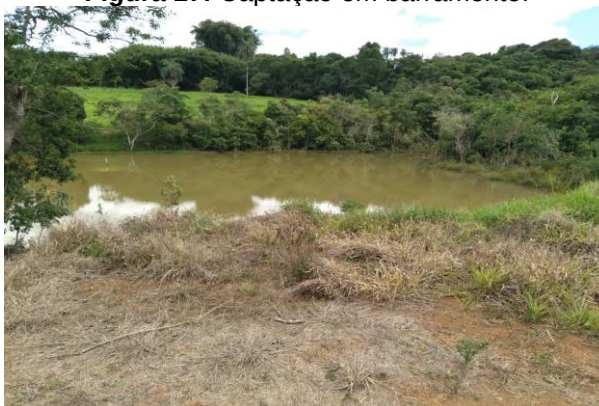
Figura 17: Captação em barramento.
