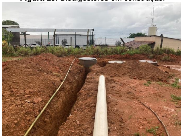
Figura 13: Biodigestores em construção.
